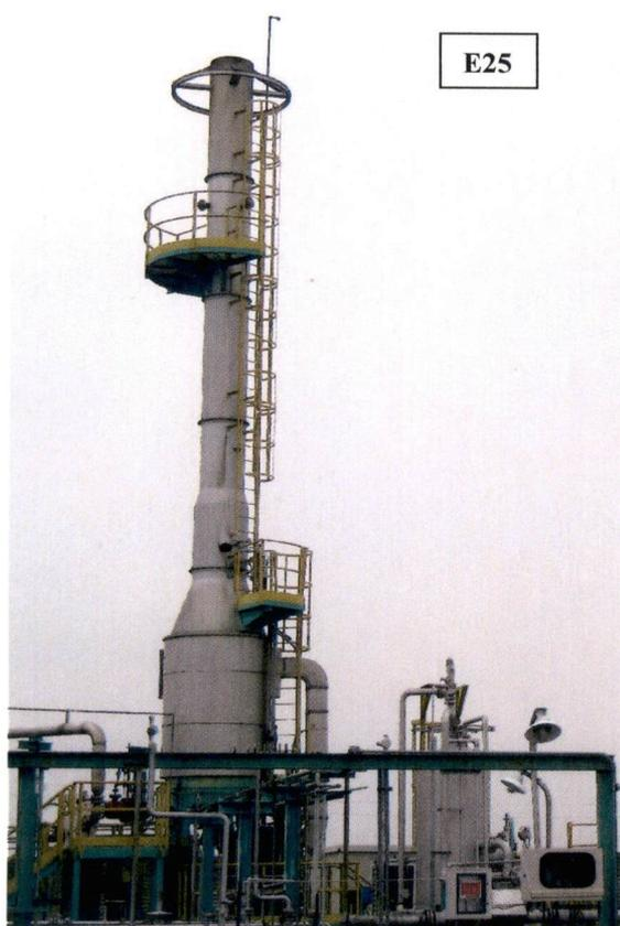
Fig. 3: Punto di emissione E25 termodistruttore
