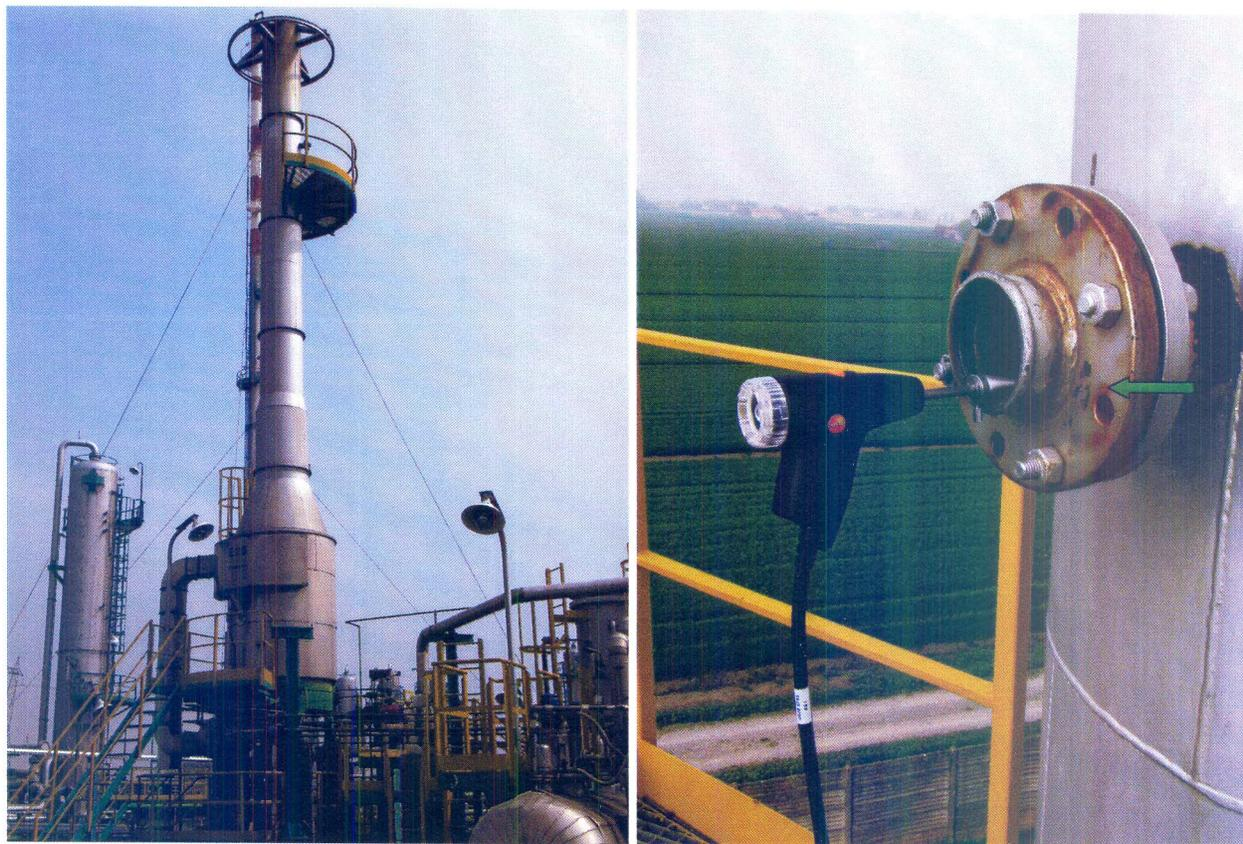
Foto 3: termodistruttore e punto di prelievo nel camino E25 (freccia verde)
