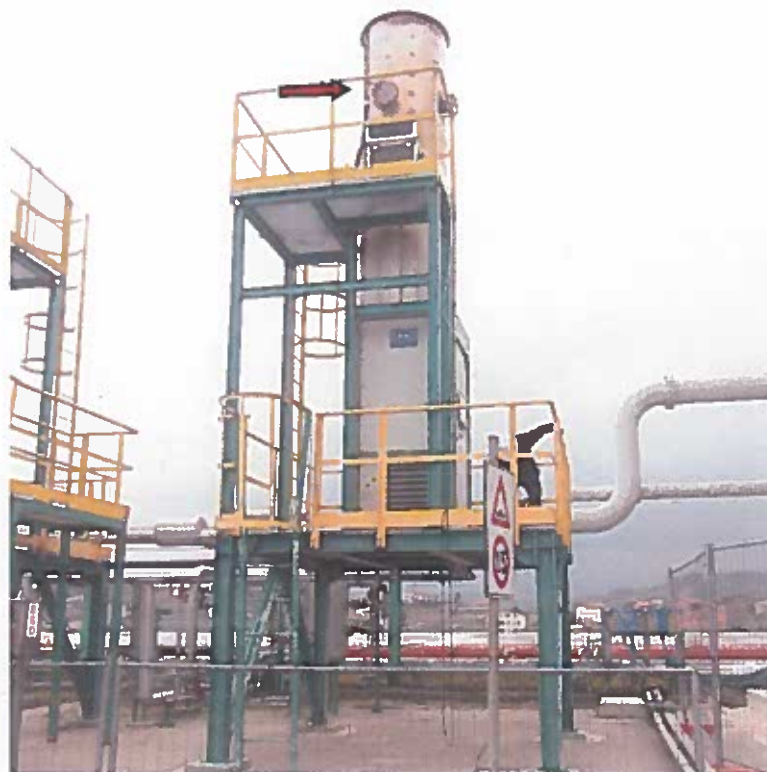
Fig. 4 Torcia CEB 02 (la freccia rossa indica il punto di prelievo dei fumi)
