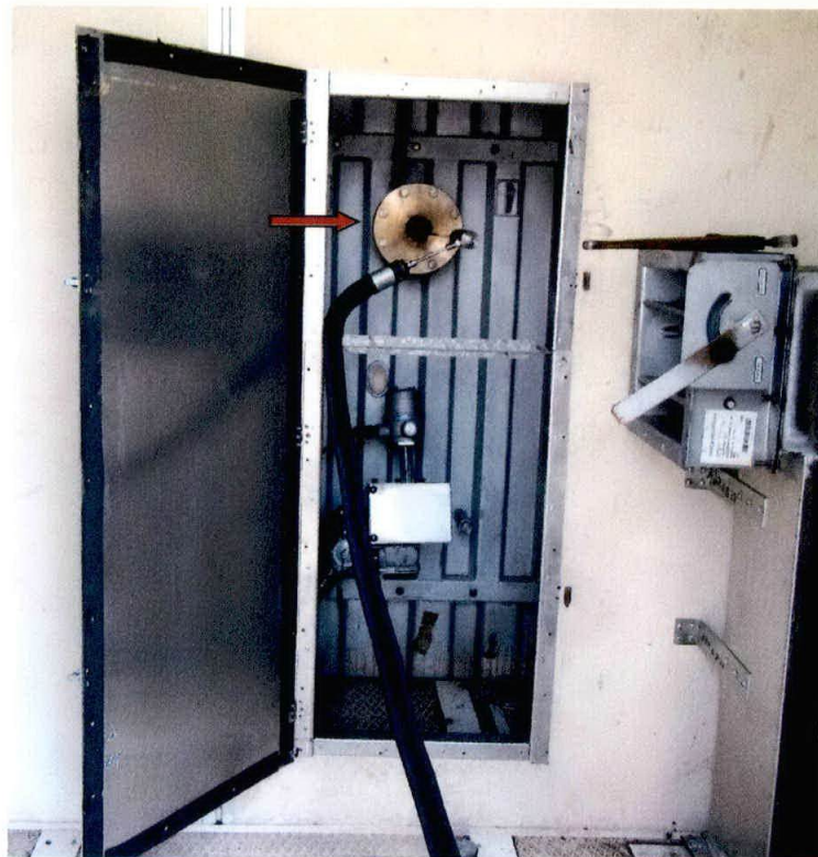
Fig. 5: Punto di prelievo dei fumi (freccia rossa)
