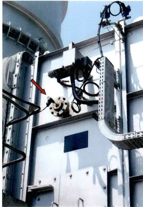
Fig. 3: Punto di prelievo dei fumi (freccia rossa)
