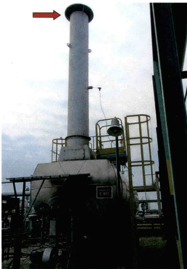
Foto 8: Punto di emissione E005 riscaldatore condensati
