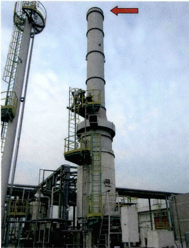
Fig. 4: Punto di emissione E011 termodistruttore AFJ001 Foto 5: Punto di prelievo dei fumi (freccia rossa)
