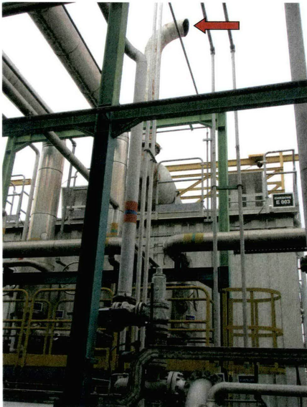
Foto 2: Punto di emissione E003 motocompressore MG406
