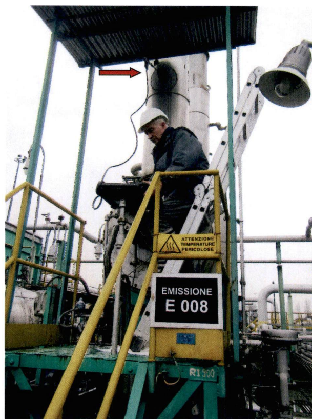
Fig. 4: Punto di prelievo dei fumi (freccia rossa)
