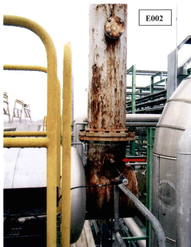
Fig. 3: Punto di prelievo dei fumi (freccia rossa)
