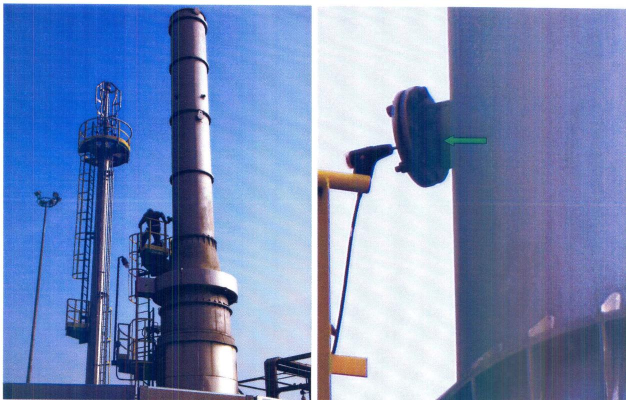
Foto 3: termodistruttore e punto di prelievo nel camino E011 (freccia verde)
