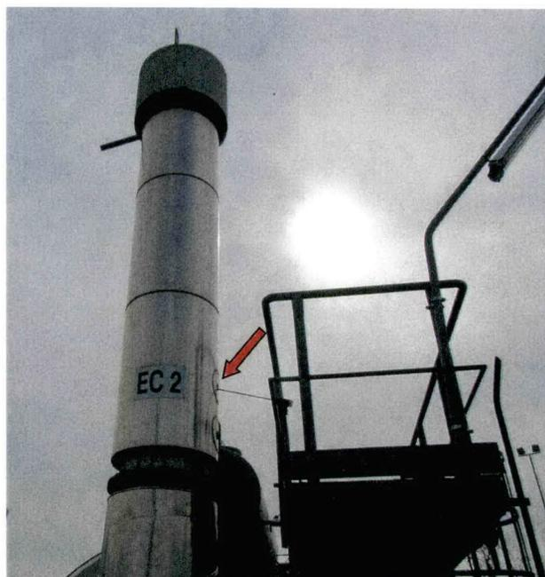
Foto 7 - punto di campionamento con sonda di prelievo
