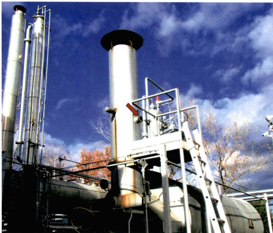
Fig. 2: Punto di prelievo dei fumi (freccia rossa)
