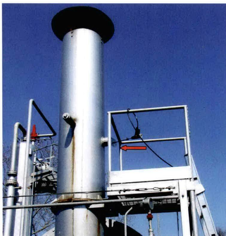
Fig. 2: Punto di prelievo dei fumi (freccia rossa)
