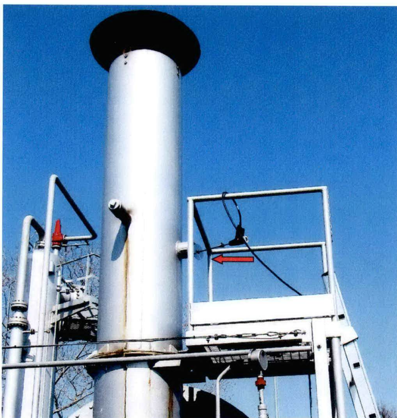
Fig. 2: Punto di prelievo dei fumi (freccia rossa)
