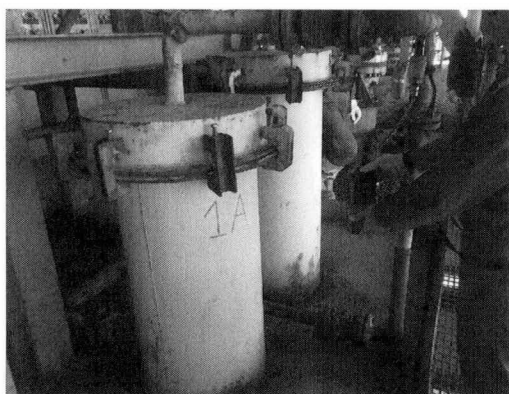
Foto 2 – Campionamento a monte filtri.
